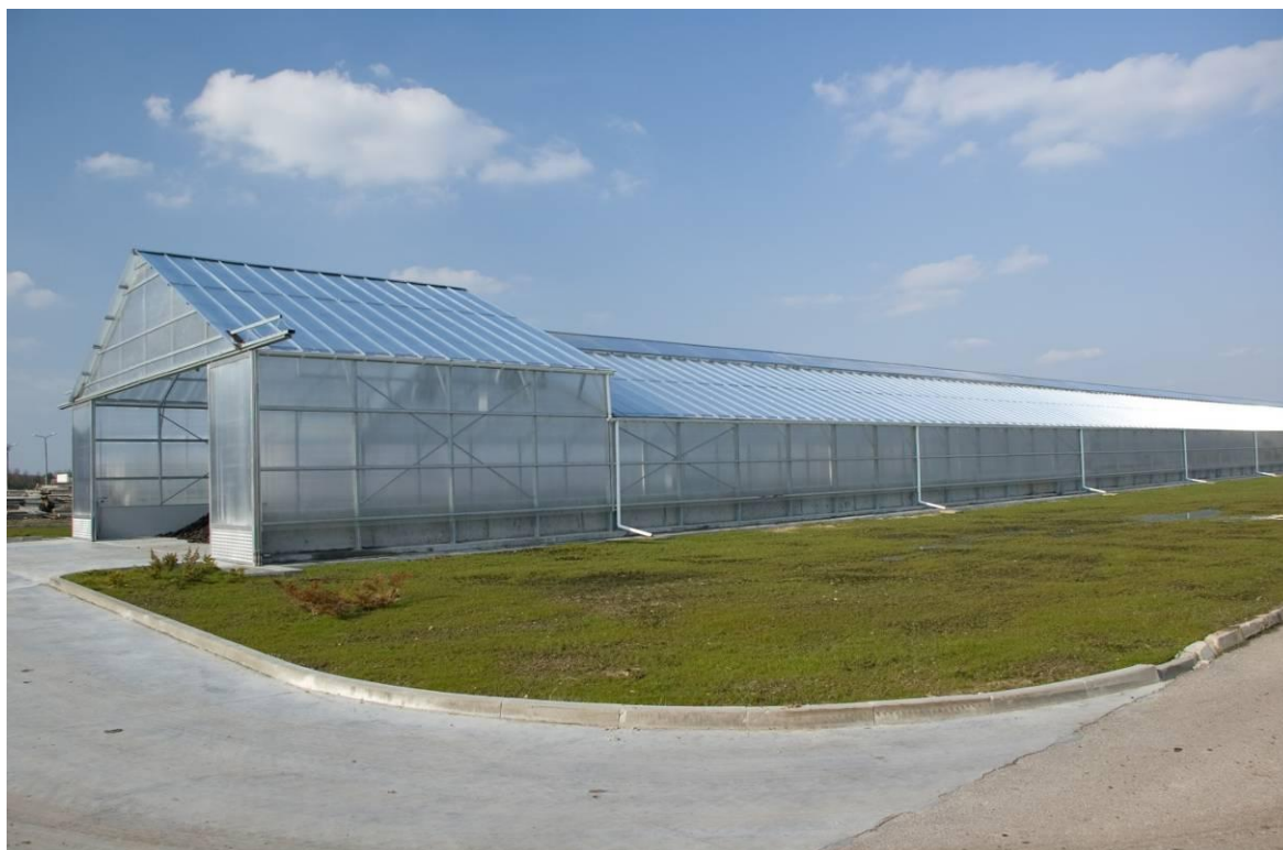
Fot 5. Hala suszarni słonecznej
