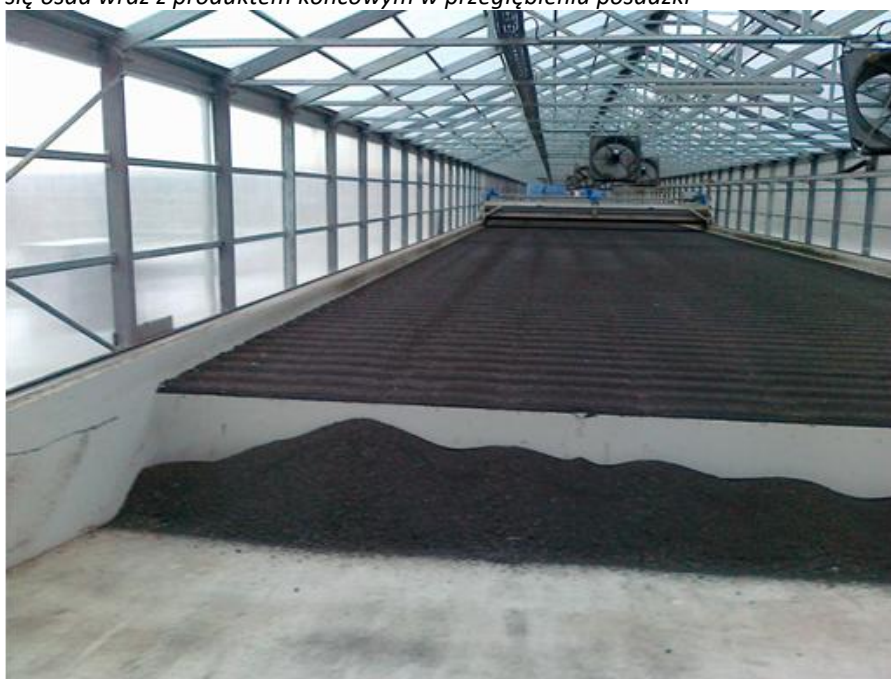
Fot.3. Suszący się osad wraz z produktem końcowym w przegłębieniu posadzki
